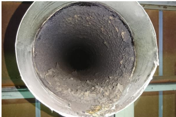
ダクト内部写真
