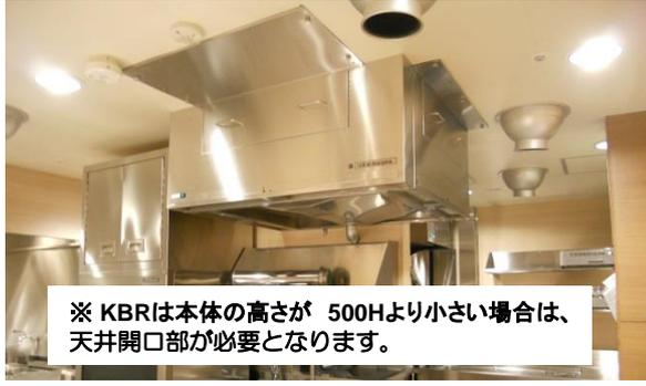
※定期メンテナンス(フィルター・ドレンパン・フード側面の洗浄・消耗部品の交換)が必要になります
