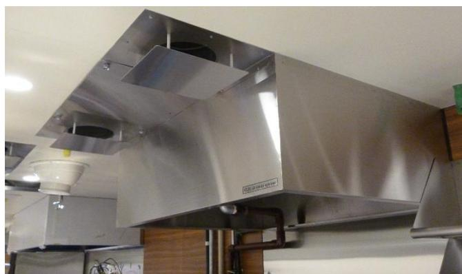
※1 外形寸法は、奥行800～1,100mm、幅900～1,600mm、高さは450mm以上で対応できます。
